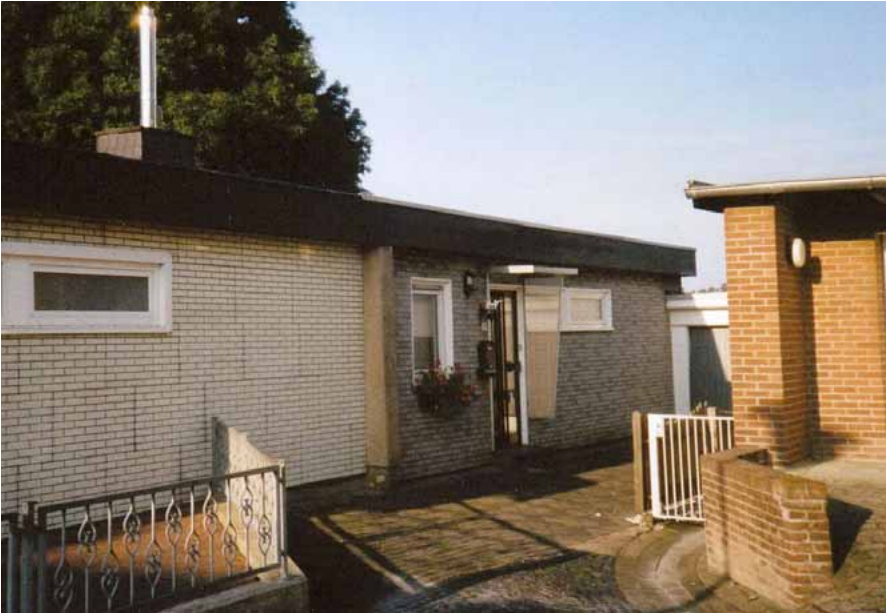
Haus Nr. 163, Heierskamp 18 vor dem Abriss im Jahre 2009
