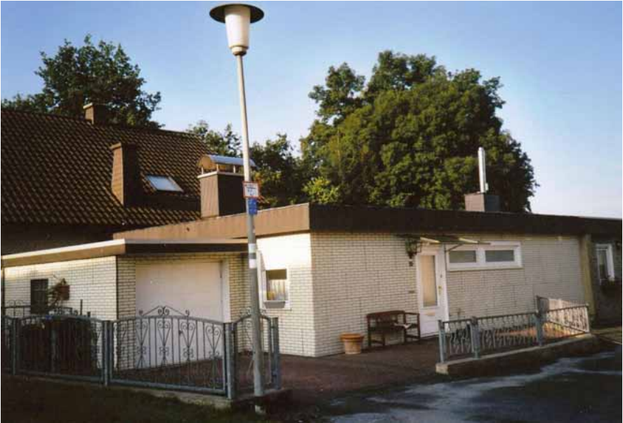
Haus Nr. 164, Heierskamp 20, vor dem Abriss im Jahre 2009
