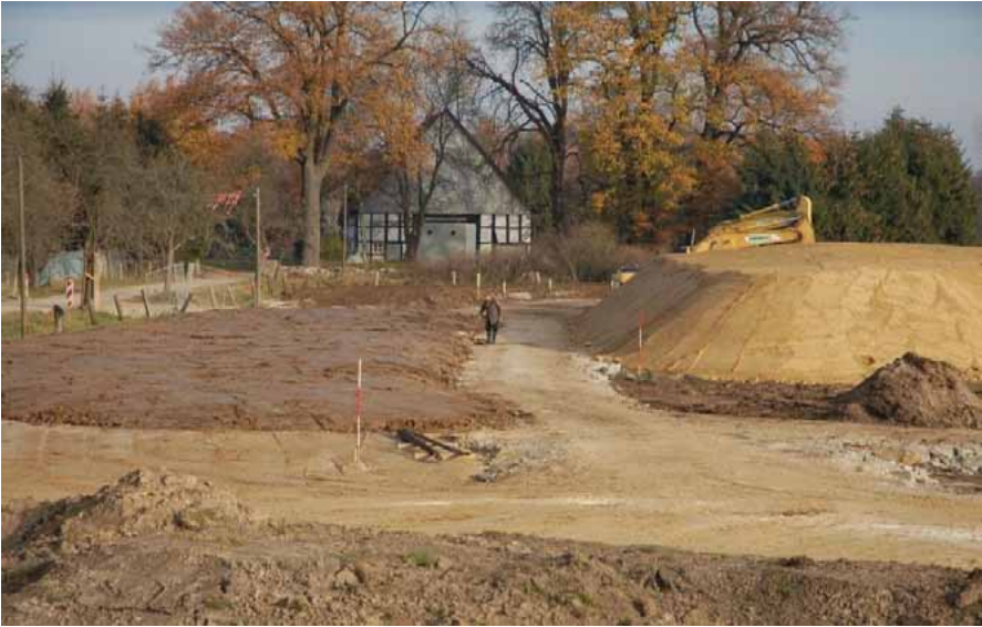
Bauarbeiten Nähe Tallehof, Foto von R.-P. Fietz im November 2011
