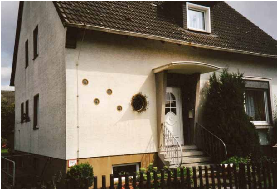
Haus Nr. 170, Lohweg 8
