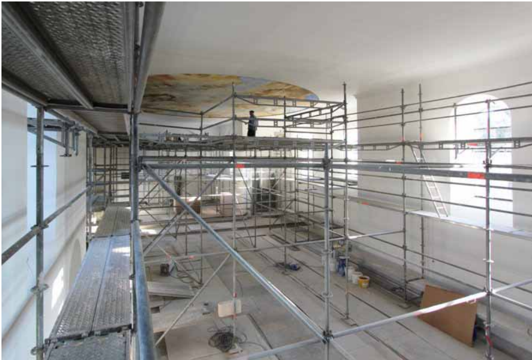
Die Kirche St. Joseph in Marienloh während der Restaurierung
