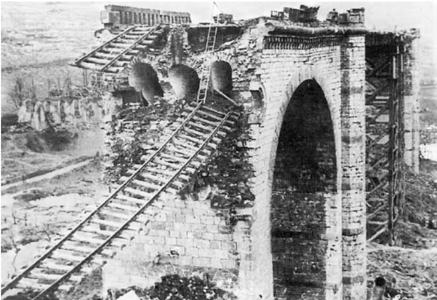
Altenbekener Viadukt nach der Zerstörung Februar 1945
