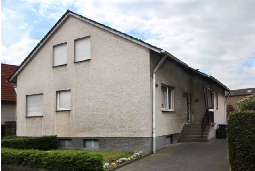
Haus Nr. 175, Detmolder Straße 376
