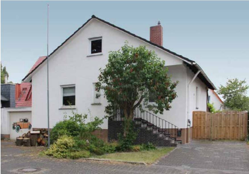
Haus Nr. 184, Detmolder Straße 380
