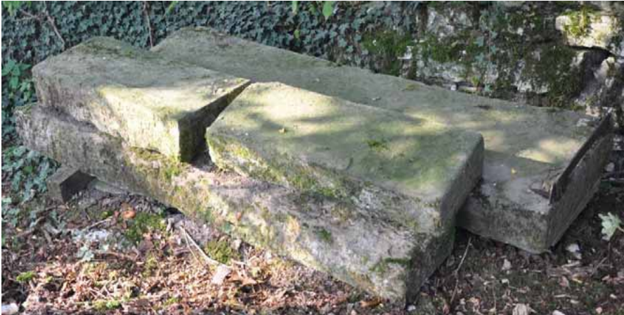
Treppenstufen im Dornröschenschlaf
