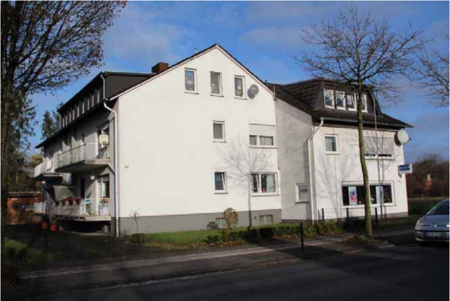
Haus Nr. 186, Detmolder Straße 367
