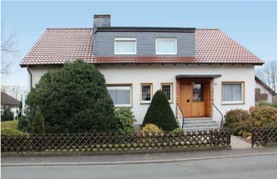
Haus Nr. 218, Lohweg 11
