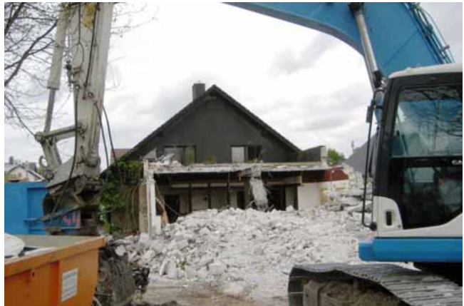
Abriss der Shilo-Ranch
