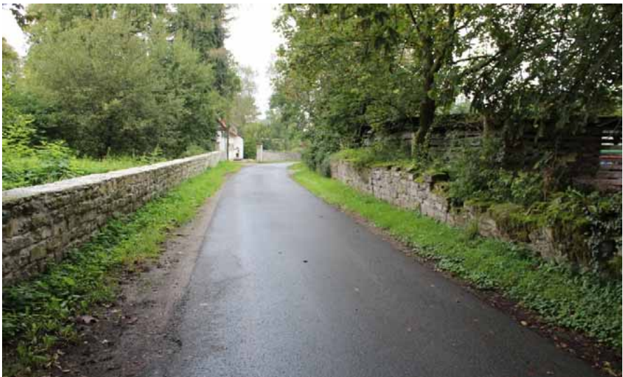
Die beiden Bruchsteinmauern an der Straße Im Lipphorn
