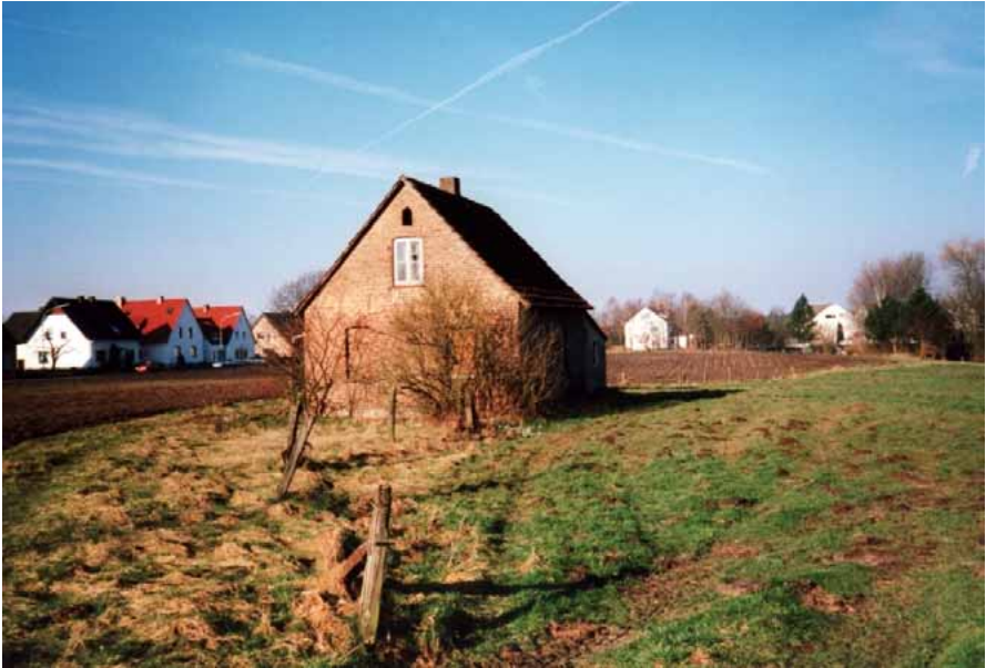
Der erdachte Alterssitz des Hermann Buse von 1835. Zunächst in Fachwerkbauweise und nach dem Brand 1908 mit Ziegelsteinen aus der anliegende Ziegelei wieder aufgebaut.
