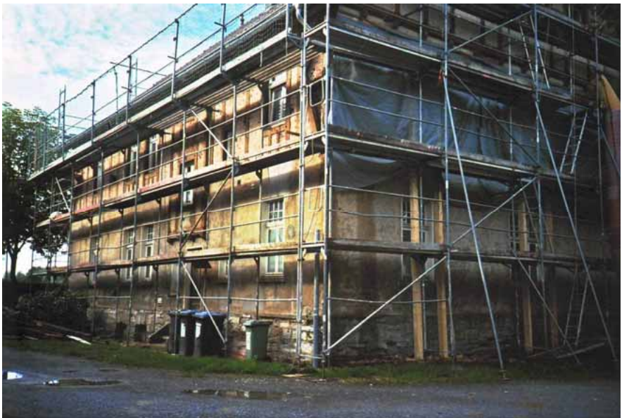
Fassadensanierung am Schäferhof Mertens - Tallmeier
