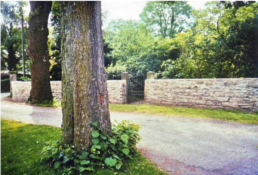
Ansicht der neu erstellten Mauer in der Hofeinfahrt
