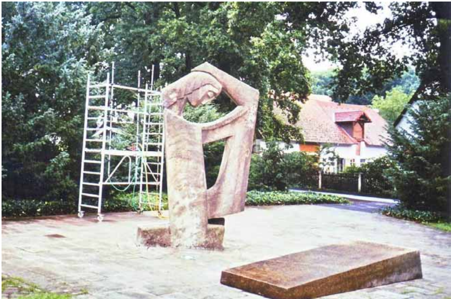
Das Marienloher Ehrenmal während der Renovierungsarbeiten
