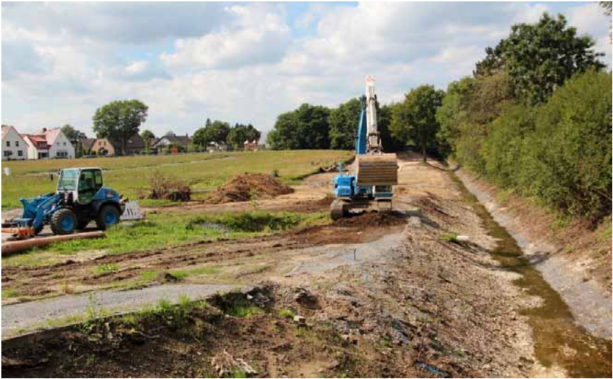
Baggerarbeiten an der Beke Anfang September 2015
