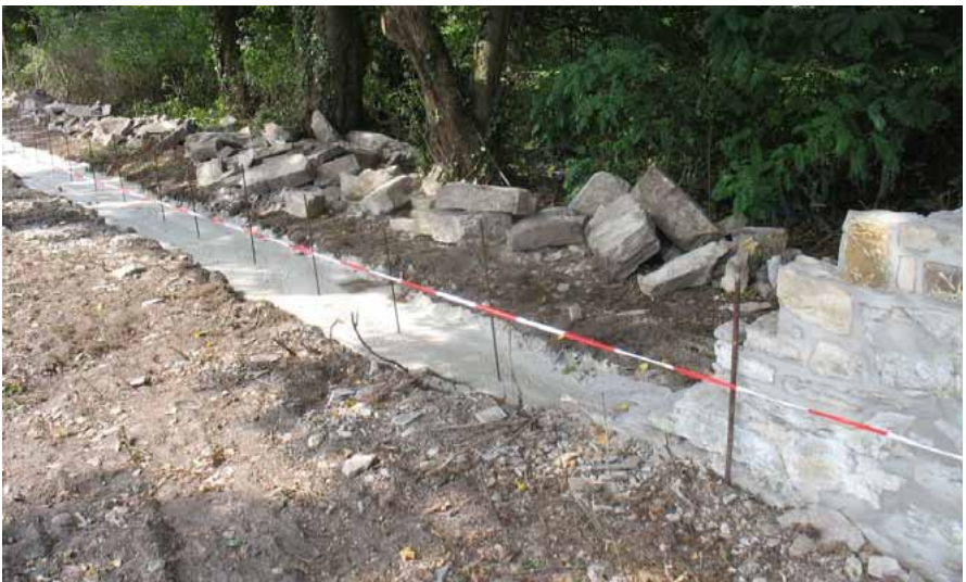
Das Fundament wird bei der Restaurierung der Mauer neu erstellt
