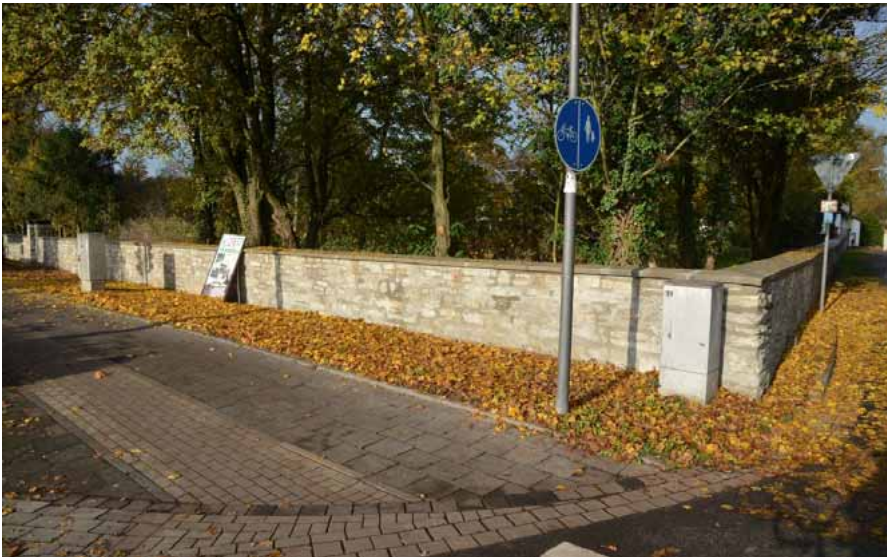
Die neue Mauer (Einmündung Im Lipphorn)
