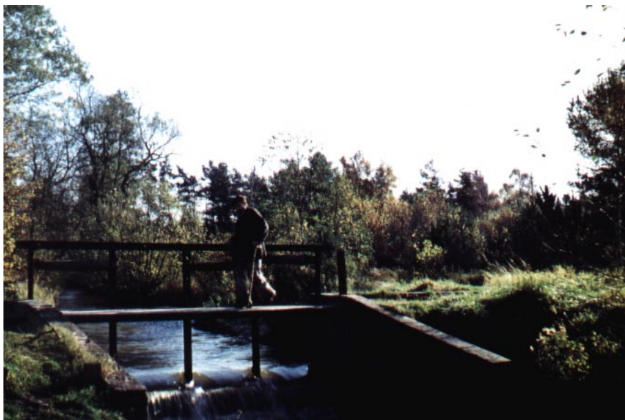
Ein Stauwerk der Strothe, früher Übergang zum Flughafen Bad Lippspringe
