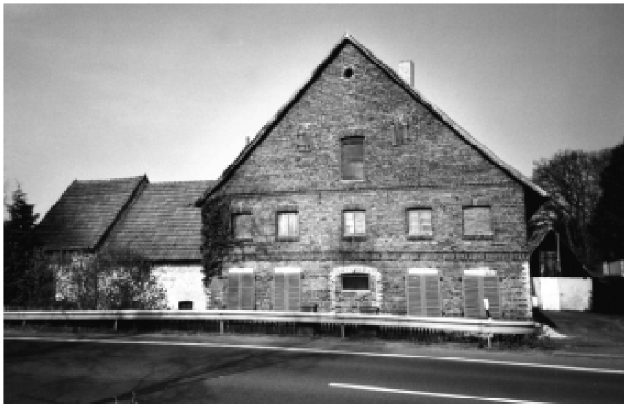
Das im Jahre 1900 neu errichtete Wirtschaftsgebäude mit Wohntrakt. Daneben die 1910 gebaute Scheune. Rechts im Bild der Standort des früheren Backhauses (Backs) heute Holzschuppen
