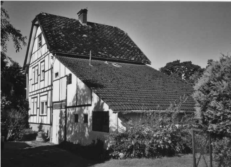
Haus Israel Nr. 74 ein ca. 150 Jahre altes Fachwerkhaus mit nachträglichen Unter- und Anbau
