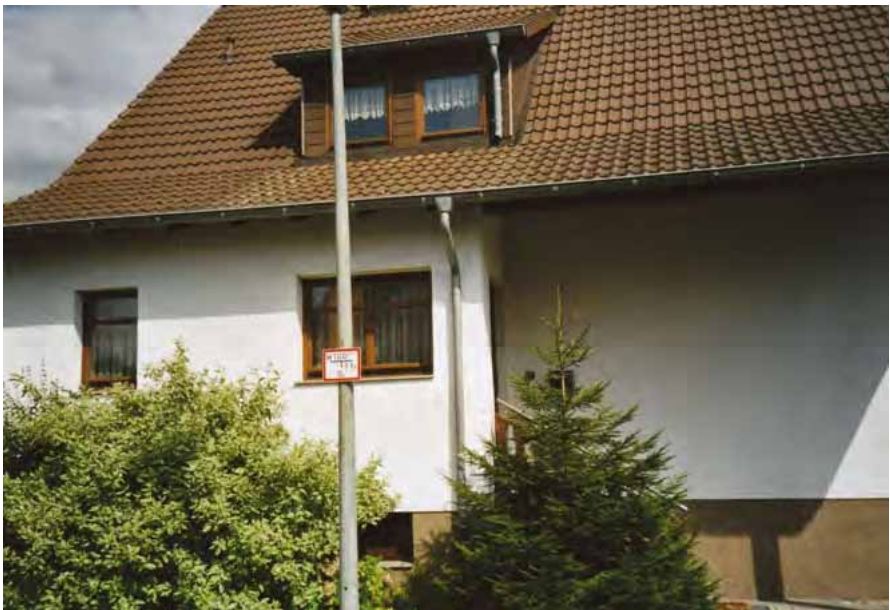
Haus Nr.156, Lohweg 10
