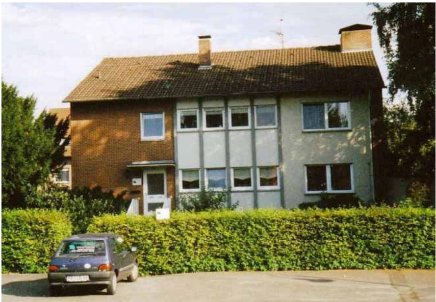
Haus Nr. 150, Detmolder Straße 386
